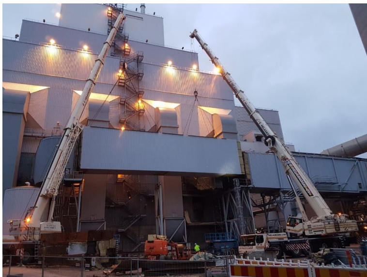
Anheben des letzten ESP-Schachtes im Stora Enso-Werk Imatra (mit freundlicher Genehmigung von Stora Enso).
